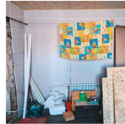
Nach einem Brand wird die Wohnung renoviert. Foto: Caritas Sibirien
