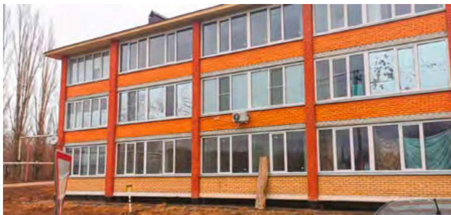
In diesem Haus wurden zwei Wohnungen fertig gebaut, Foto: Friedhelm Lange
