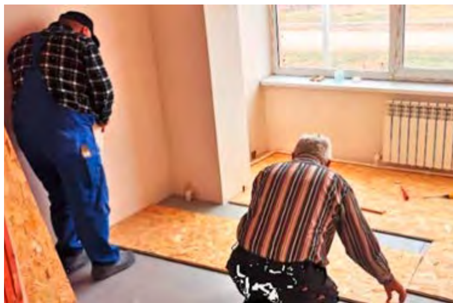
Isolierung und Trittschall wurden verlegt, Foto: Friedhelm Lange
