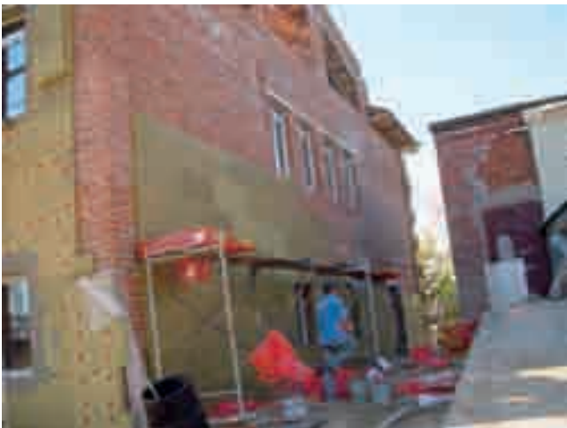
Die Isolierung der Außenfassade ist bald abgeschlossen, die neuen Heizungssysteme sind montiert und der neue Dachstuhl ist fast fertig. Auch die neuen Fenster konnten schon eingesetzt werden. Fotos: Caritas.
